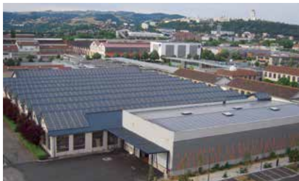
Installation de 469 kW HEF à St-Etienne
