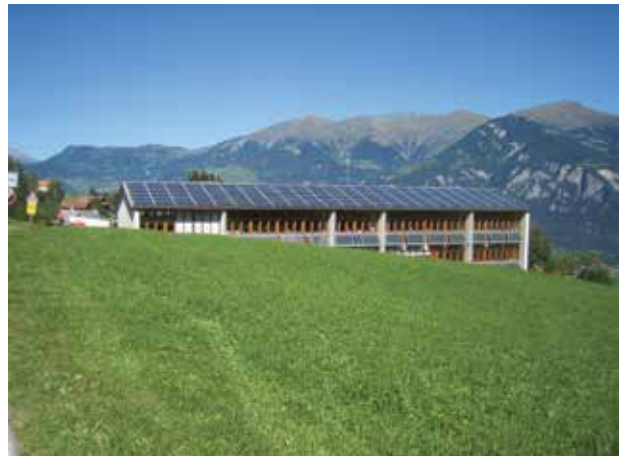
Une des installations solaires vendues: la centrale de 31 kW aménagée sur l'école de Flerden et mise en service en 2007.
